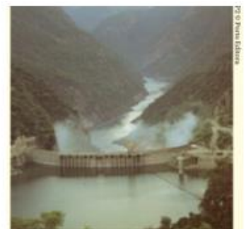
Barragem de Cahora Bassa em Moçambique.
